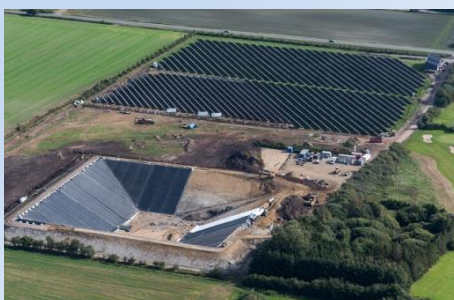
Solární teplárna / Dánsko
